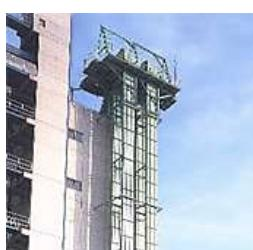
つばきNBKパケットエレベータは、穀物・飼料副原料・飼料製品専用の、ベルト式遠心排出型パケットエレベータです。
